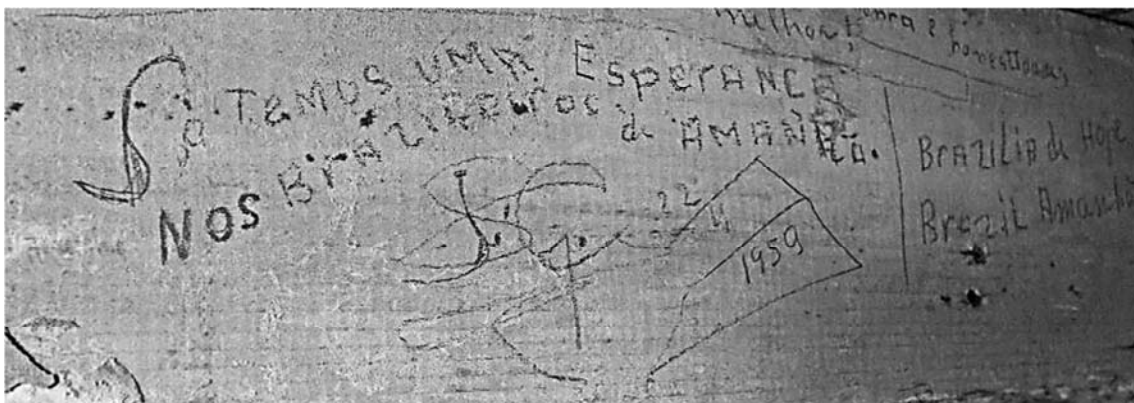
Mensagens deixadas nas lajes do prédio do Congresso Nacional pelos operários que trabalharam na construção de Brasília. “Só temos uma esperança, nos brasileiros de amanhã. 22/4/1959” / “Brasília de hoje, Brasil amanhã”. In: Internet: <www2.camara.leg.br>.
